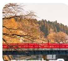
สะพานนากะบาชิ
