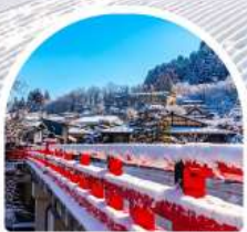
สะพานนากะบาชิ
